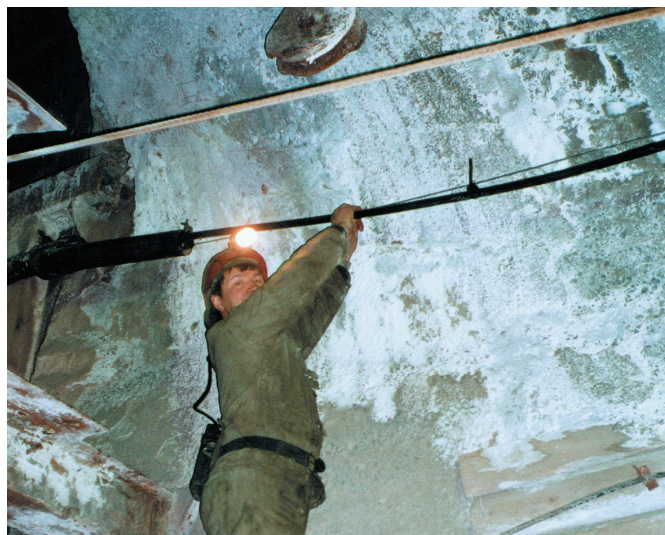
Монтаж подземной телекоммуникационной сети комплекса «Талнах»
